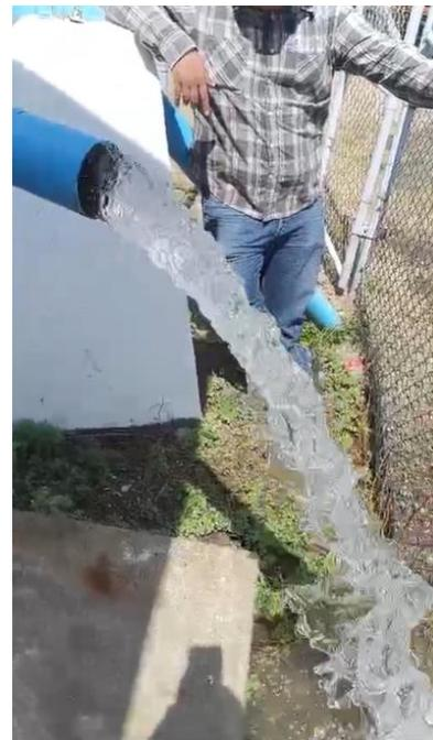
Rehabilitación de pozo aeropuerto y pozo de agua zarca, con una profundidad de 100 m y con ademe de 8" de diámetro, en la localidad de Nacozari de García
