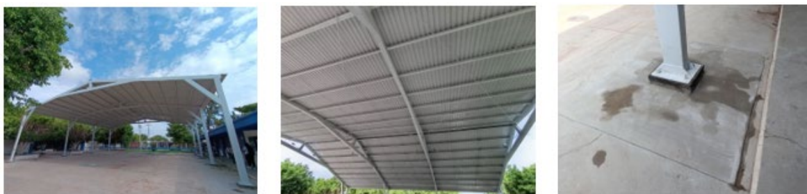
Centro de Estudios de Bachillerato 6/14 Joaquín Baranda
