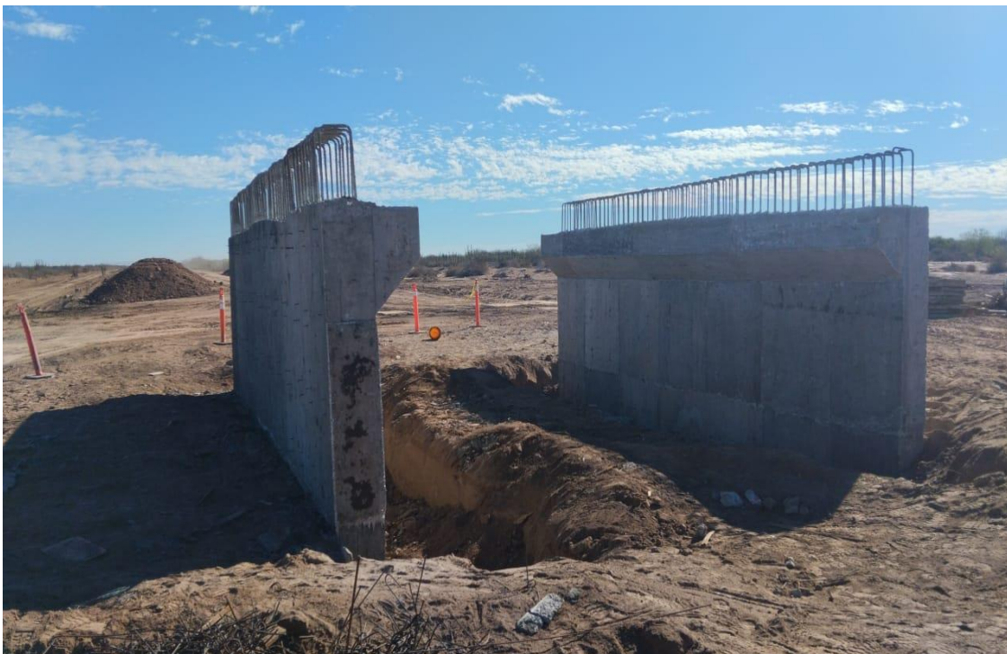
Muros en Puente Vehicular del Km 51+813
