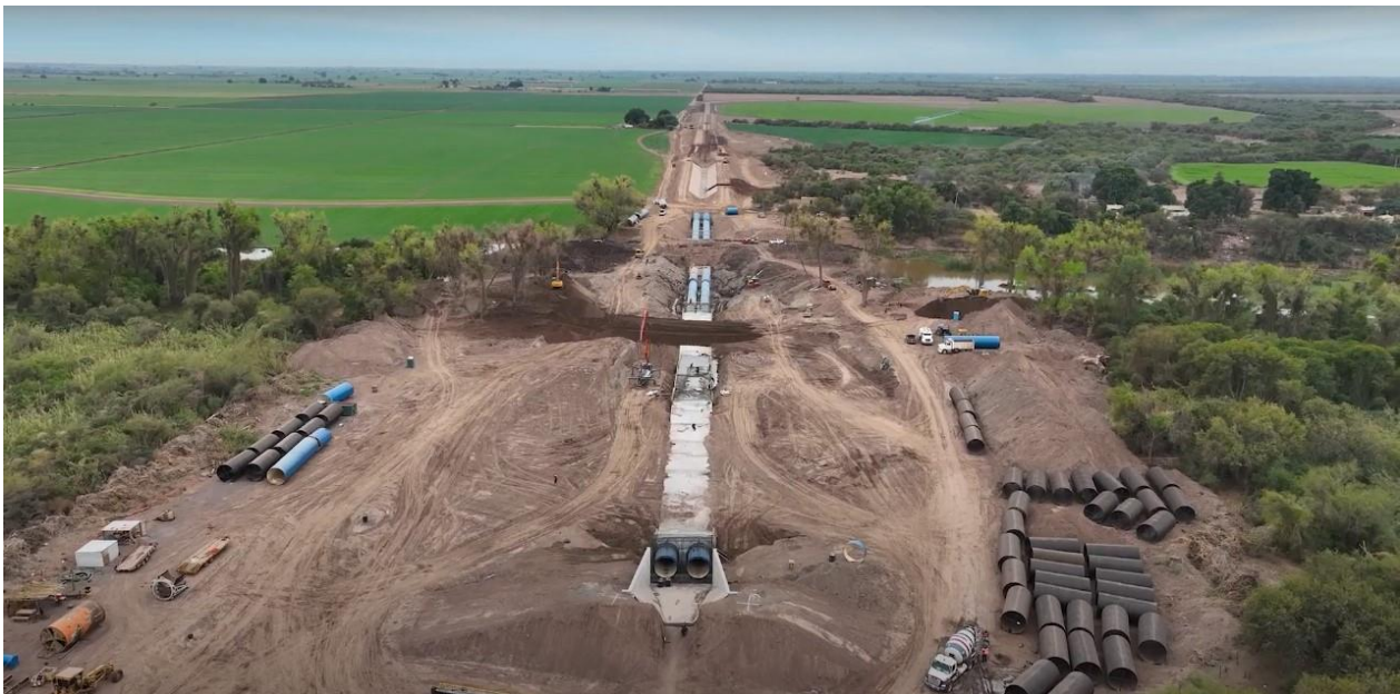
Revestimiento de canal con concreto F'c= 140 \text{ kg/cm}^2
