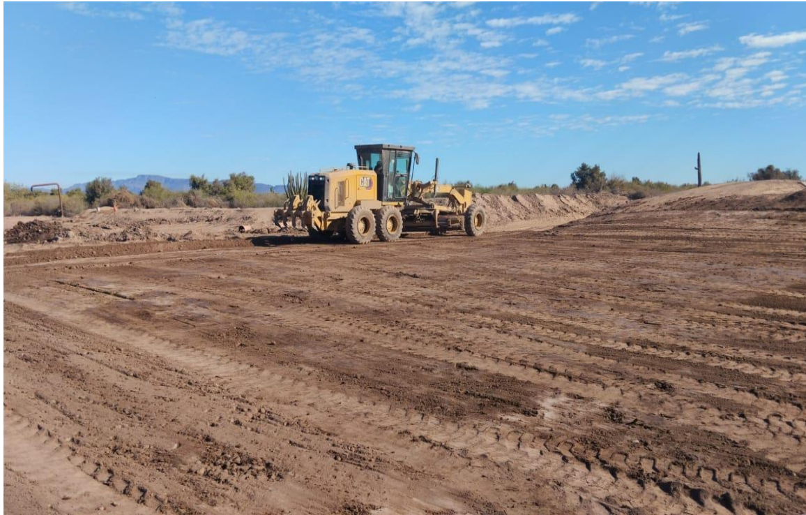
Trabajos de conformación sobre paso de tubo encamisado km 41+560
