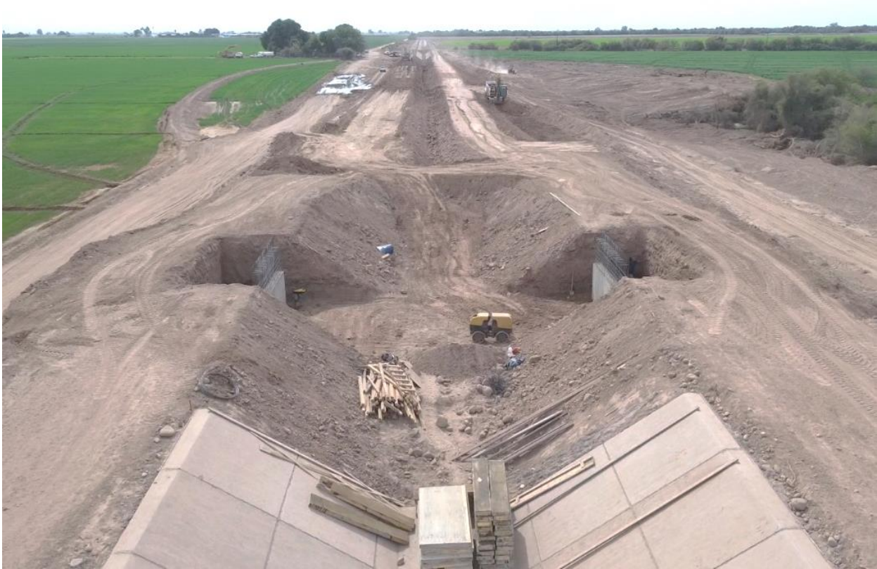
Revestimiento de canal con concreto F'c= 140 \text{ kg/cm}^2
