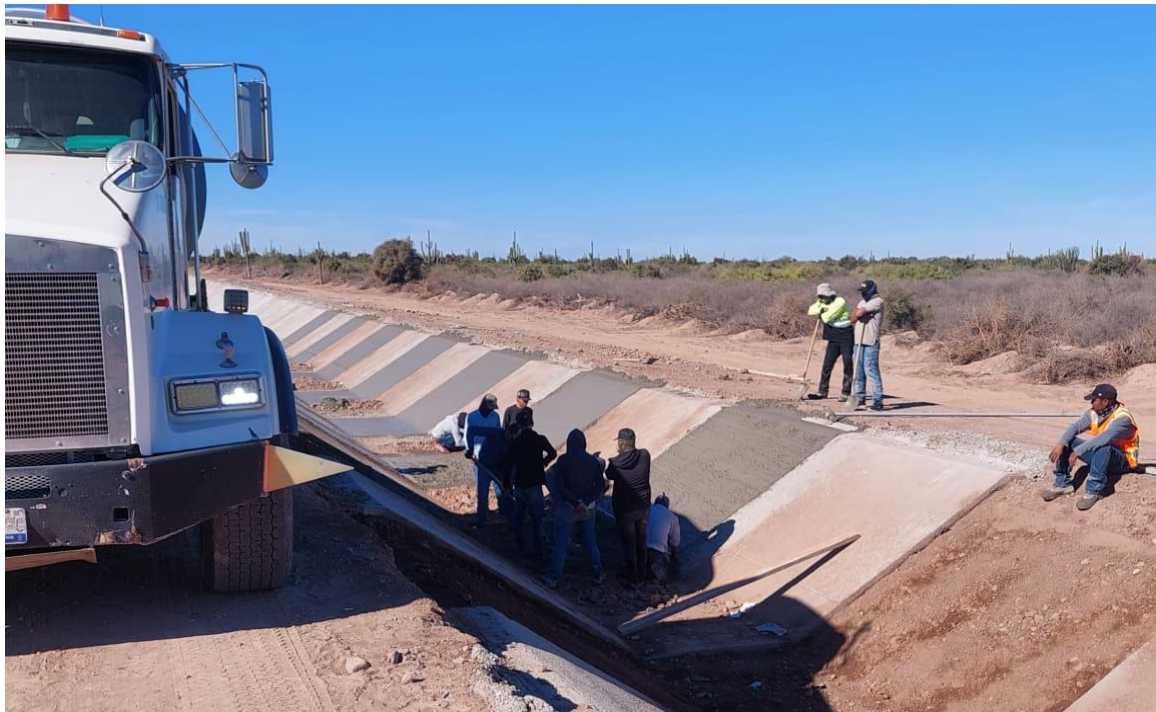
Revestimiento de canal con concreto 40+000
