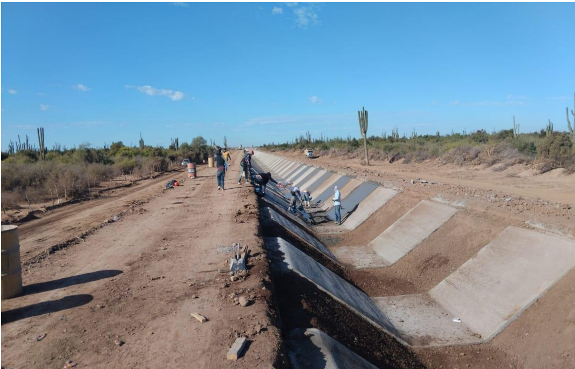
Concreto en canal km 40+360
