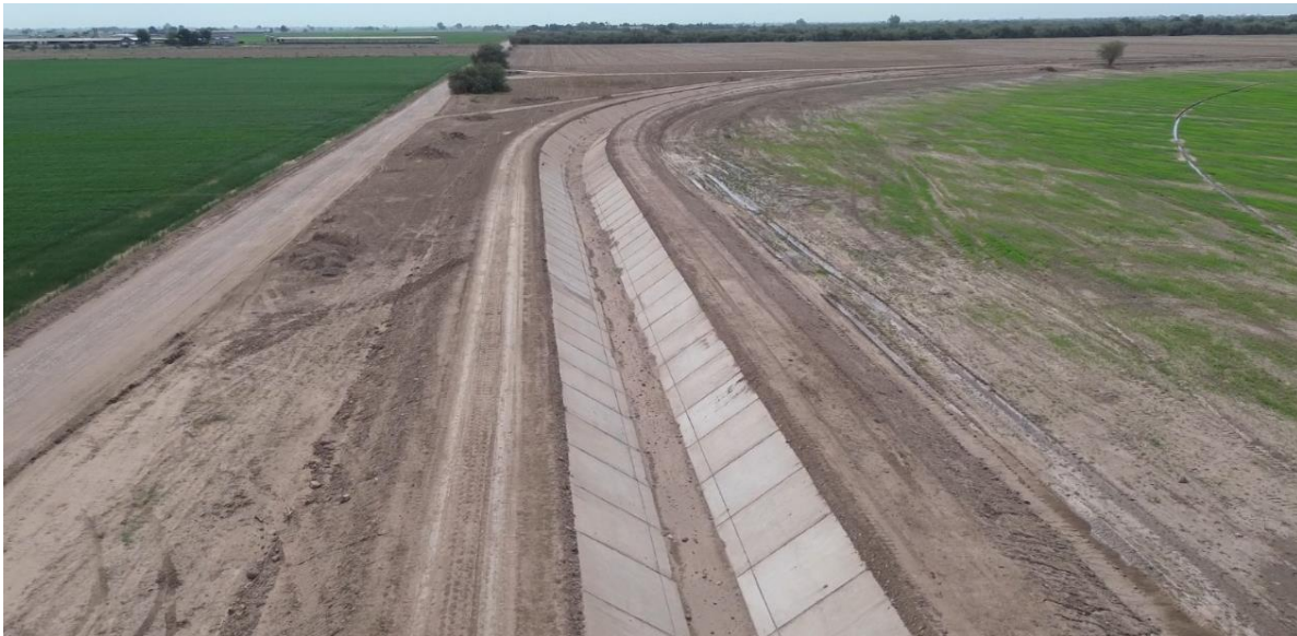
Tramo de canal principal terminado
