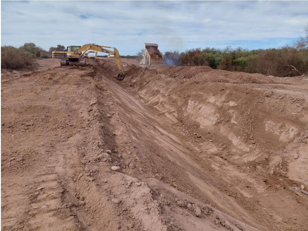
Conformación de cubeta del canal.
