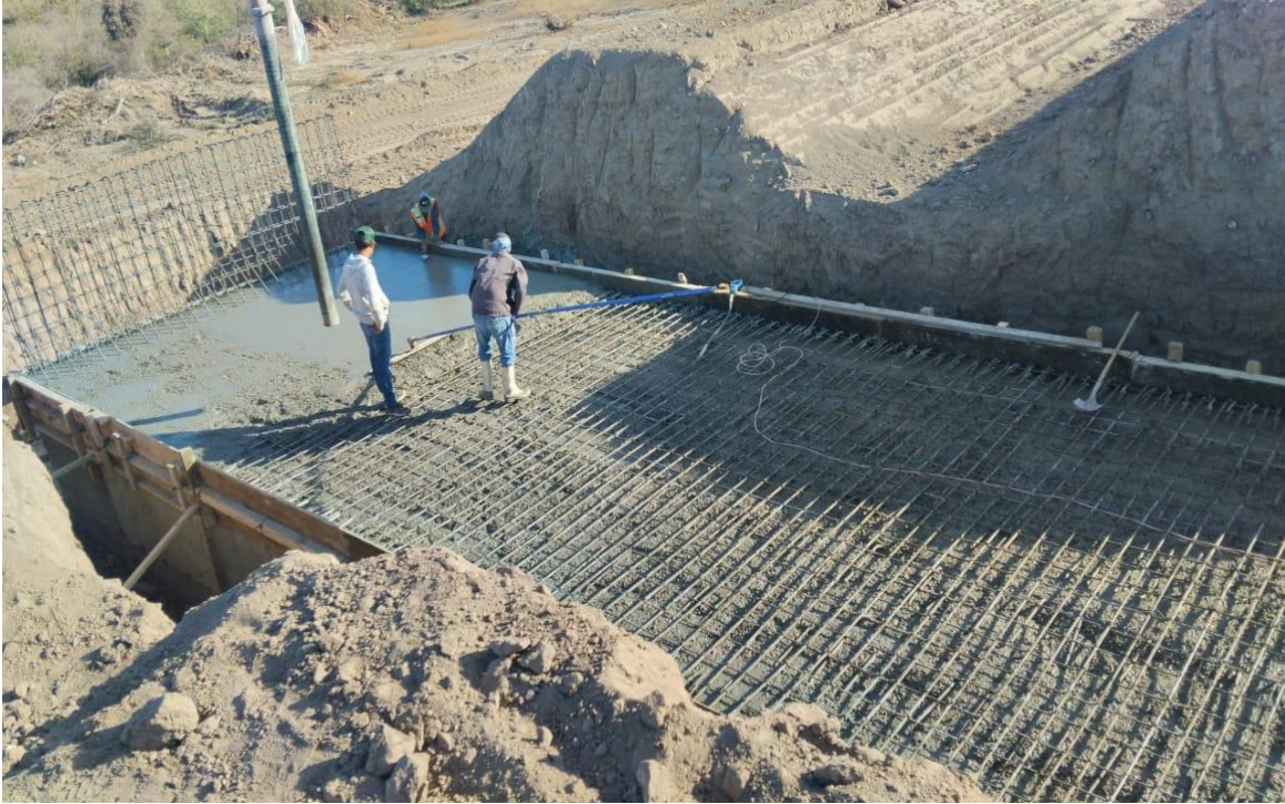
Colado de losa de Paso Inferior en el Km 42+520
