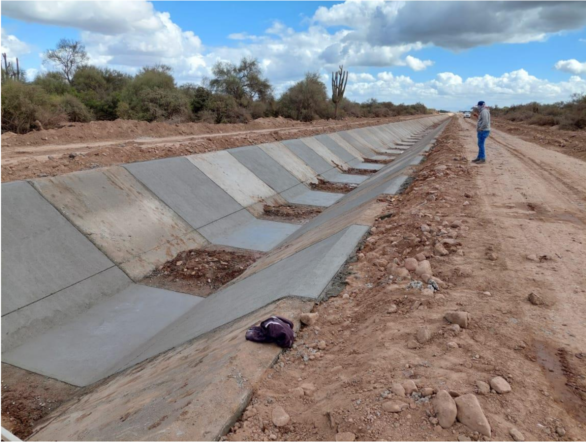
Revestimiento de canal con concreto F'c= 140 \text{ kg/cm}^2
